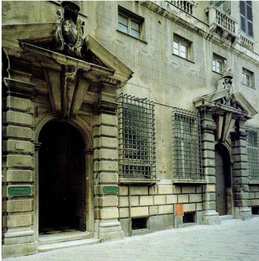
1 - Fotografia b/n; "Portali manieristi affiancati sulla facciata"; (Caraceni 1992; p. 121)
