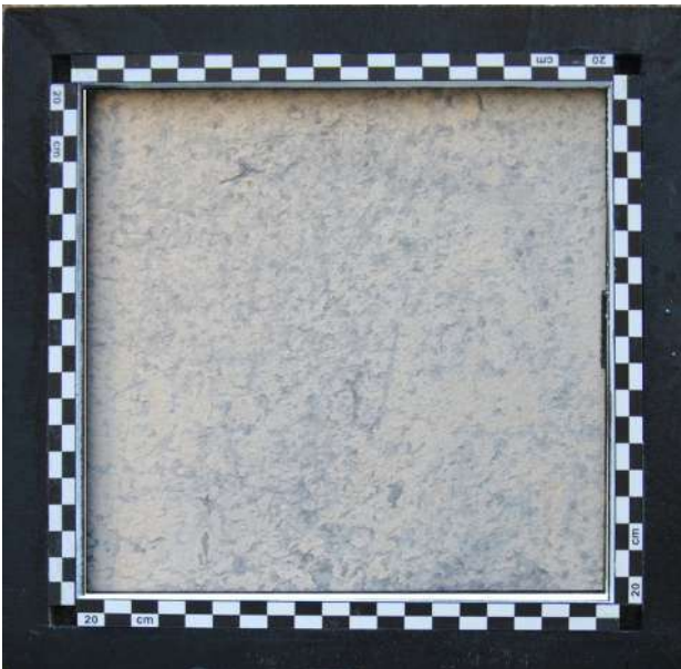
Figura 9 – Palazzo di Giacomo Spinola di Luccoli (N. 5), rivestimento del fronte a fasce bicrome elemento in calcare marnoso (tracce di scialbo superficiale)
