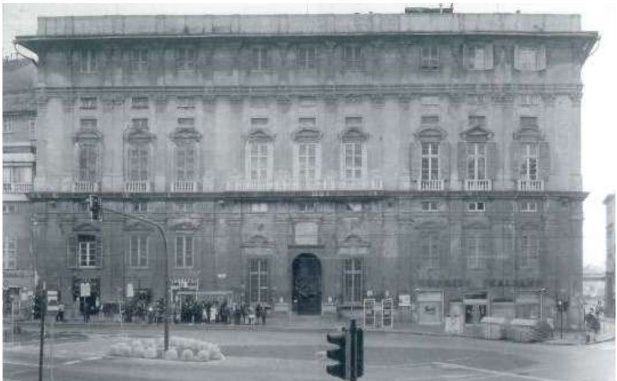
2- Fotografia b/n; facciata principale (Poleggi 1998, p. 163)
