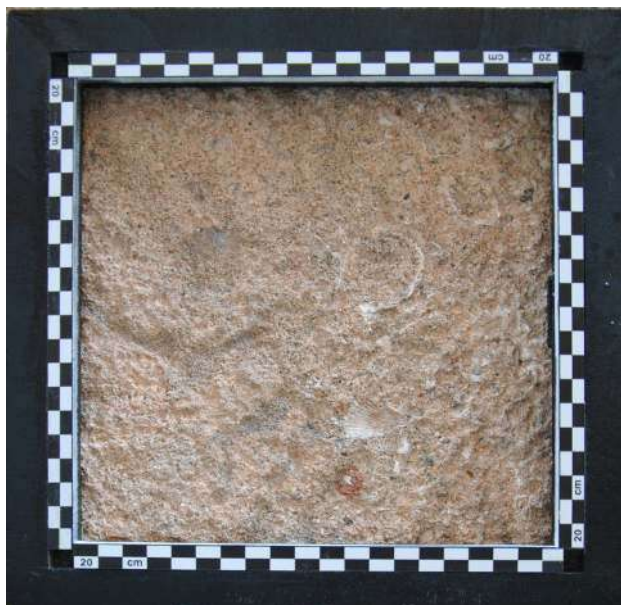
Figura 13 – Palazzo di Nicolò Grimaldi (N. 16), rivestimento del basamento dell'ala ovest in pietra di Finale
