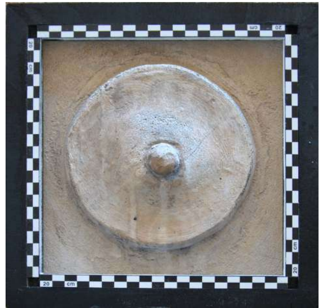
Figura 20 – Palazzo di Nicolosio Lomellini (N. 14), decorazione a rilievo realizzata a stucco
