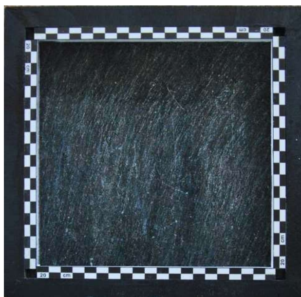
Figura 8 – Palazzo di Francesco Grimaldi (N. 36), zoccolo in lastre posate nel restauro del 1987
