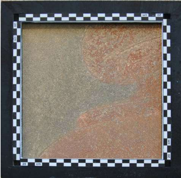
Figura 21 – Palazzo di Paolo Battista e Nicolò Interiano (N. 7), coloritura del fronte principale a fresco con terre naturali
