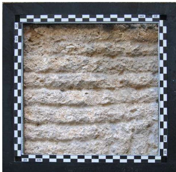
Figura 14 – Palazzo di Cipriano Pallavicini (N. 34), rivestimento del fronte a bugnato a cuscino rigato in pietra di Finale
