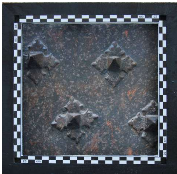
Figura 15 – Palazzo di Nicolosio Lomellini (N. 14), rivestimento in lamina di ferro con chiodi forgiati
