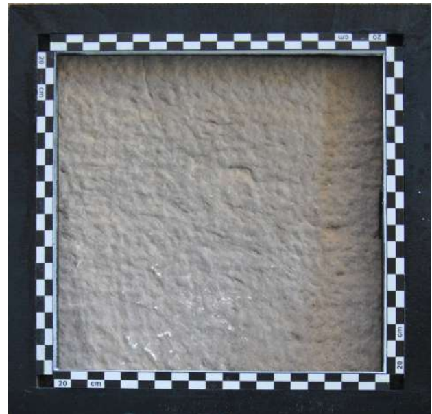
Figura 10 – Palazzo di Agostino Pallavicini (N. 8), rivestimento del fronte a bugnato a cuscino liscio
