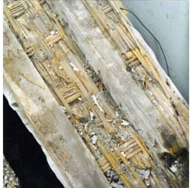
Figura 4 – Palazzo di Paolo Battista e Nicolò Interiano (N. 7), particolare dell'estradosso di volta leggera (Galliani 2006, 298)
