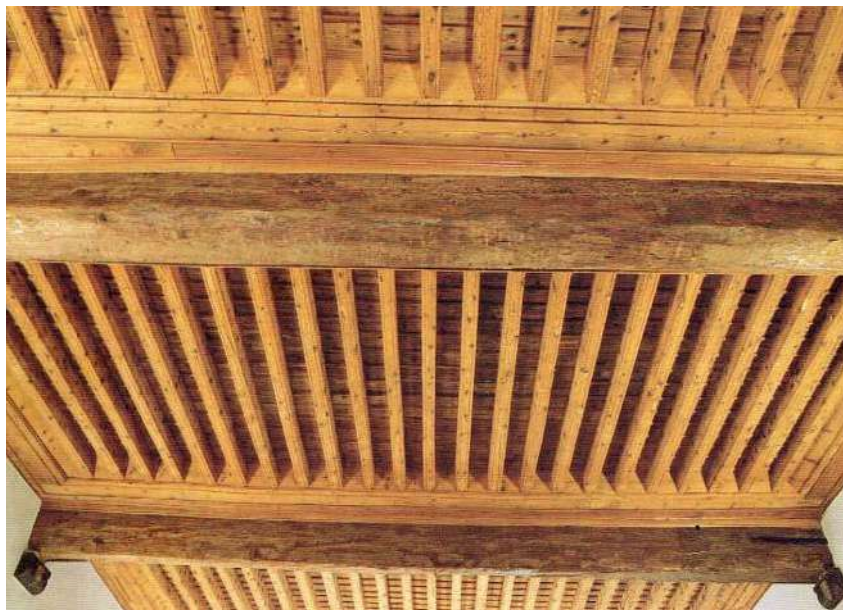
Figura 1 – Palazzo di Giacomo Spinola di Luccoli (N. 5), intradosso di solaio ligneo (Montagni 1993, 52)
