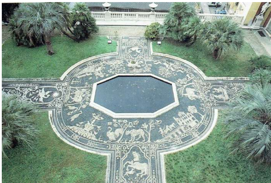
Figura 5 – Palazzo di Stefano Balbi (N. 30), pavimentazione a rissêu nel cortile in ciottoli bianchi e neri (Marchi 1993, 105)
