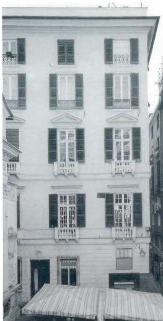
1 - Fotografia b/n; facciata principale ( Poleggi 1998, p. 80)
