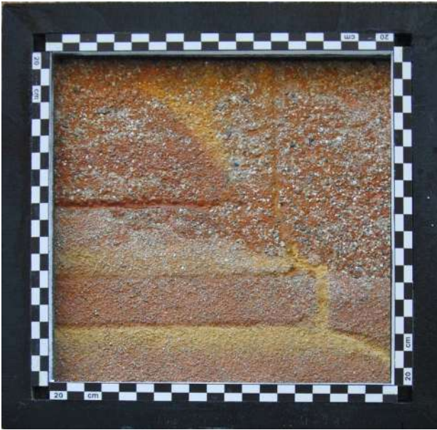
Figura 19 – Palazzo di Tobia Pallavicino, via Garibaldi 4 (N. 11) facciata su piazza del Ferro, è possibile vedere la malta e in basso il rifacimento più recente dell'intonaco, probabilmente per ovviare al degrado dovuto all'umidità di risalita.
