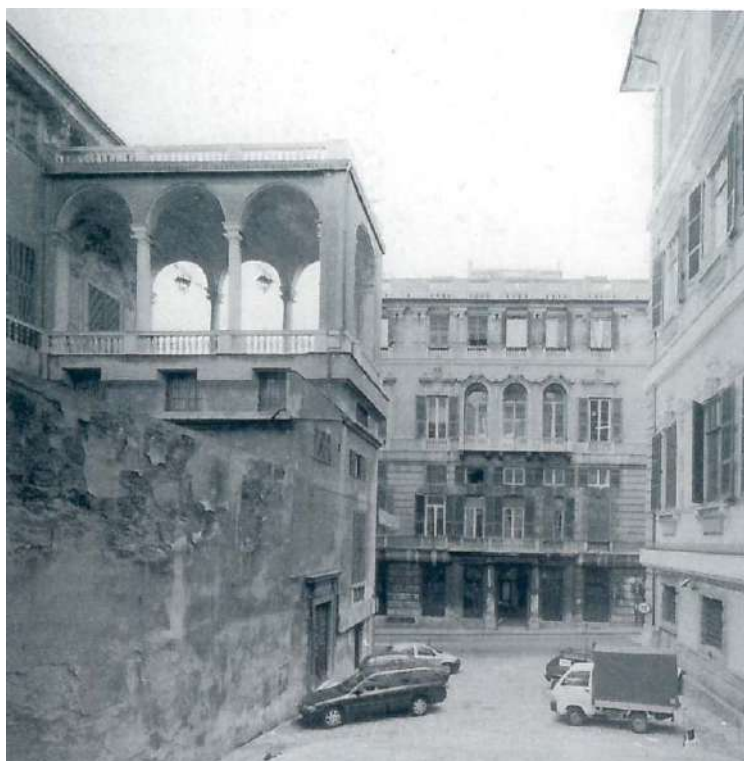
1- Fotografia b/n; facciata principale (Poleggi 1998, p. 159)
