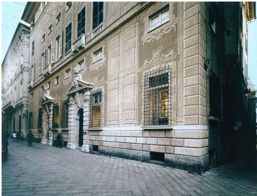
2 - Fotografia a colori; "Palazzo di Lazzaro e Giacomo Spinola oggi Cattaneo Adorno (via Garibaldi 8-10), 1583, la facciata con i portoni d'ingresso alle due abitazioni"; (Polleggi 2004; p. 108)
