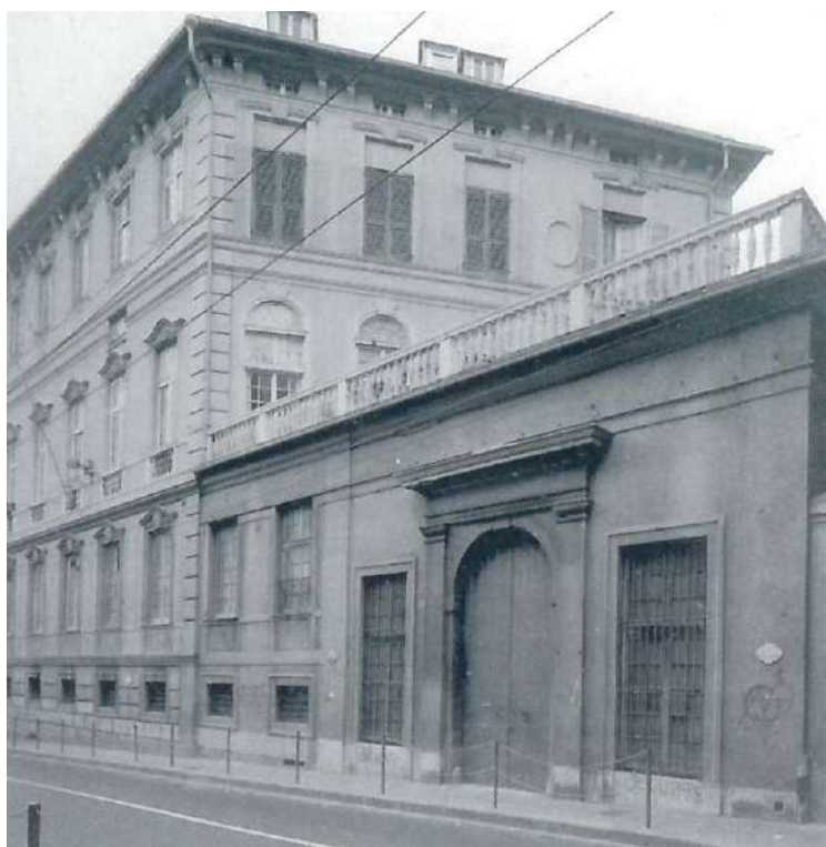
1- Fotografia b/n; facciata principale su via Balbi (Poleggi 1998, p. 161)
