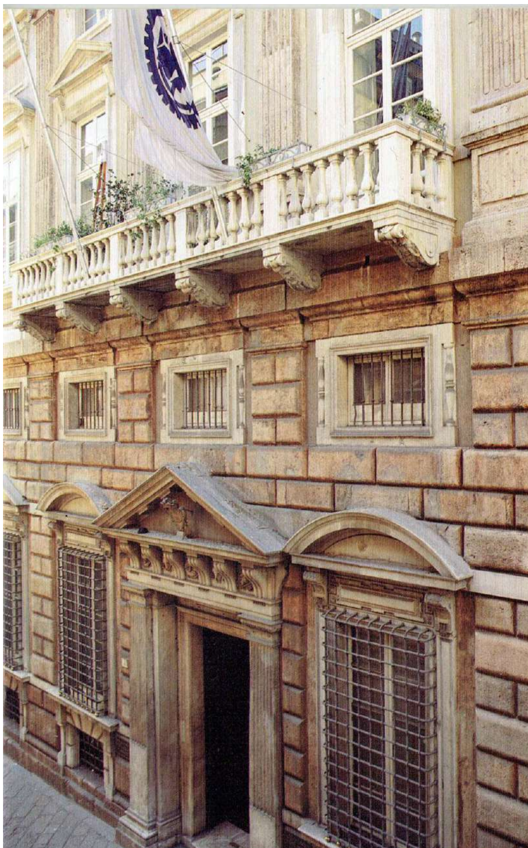
1 - Fotografia b/n; "Facciata principale su via Garibaldi"; (Bartolini Carrega 1977; p. 9)
