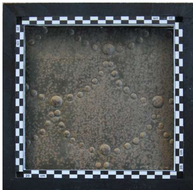
Figura 16 – Palazzo di Franco Lercari (N. 10) rivestimento in lamina di ferro e motivo decorativo realizzato con borchie e teste di chiodi disposte a ventaglio (Galliani 2006, 259)
